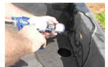
2/ Pose du mastic EPDM
