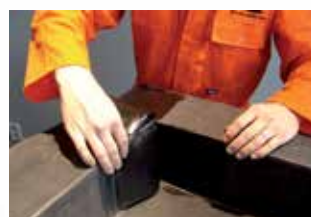
2/ Pose du Flashing pour parfaire l'étanchéité de l'angle
