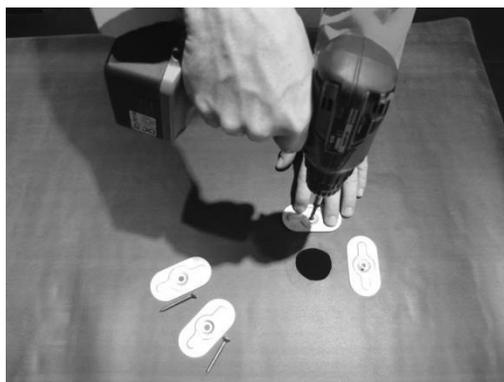
Fixer mécaniquement la membrane EPDM au moyen de quatre plaquettes de répartition de pression
