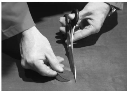
Découper la membrane au niveau de la sortie de l'EP
