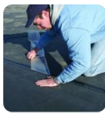
Fermeture du joint entre membrane EPDM
