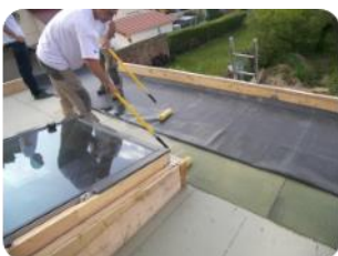
Encollage de la membrane EPDM
