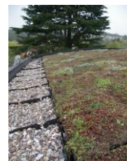
Pose des bacs pré végétalisés avec bande stérile
