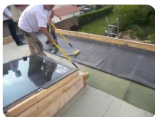
Encollage de la membrane EPDM
