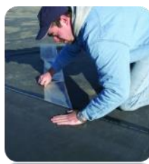
Fermeture du joint entre membrane EPDM
