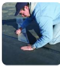
Fermeture du joint entre membrane EPDM
