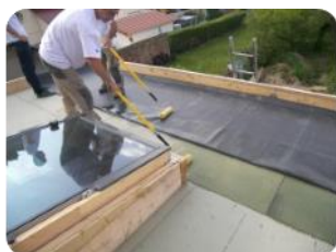
Encollage de la membrane EPDM
