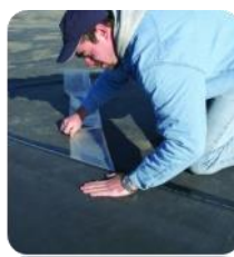
Fermeture du joint entre membrane EPDM
