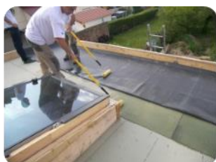
Encollage de la membrane EPDM
