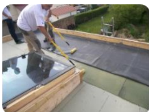
Encollage de la membrane EPDM
